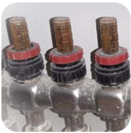
Jakotukin virtausmittarien samentumat
