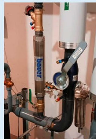
Bauer-laite asennettuna lämmityskierto.
